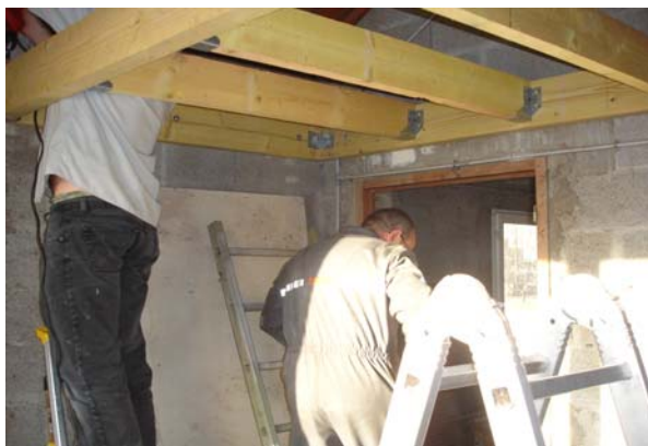
Assemblage des pannes et sabots sur les bastaings
