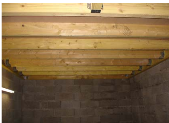
Vue d'ensemble de l'ossature support plancher
