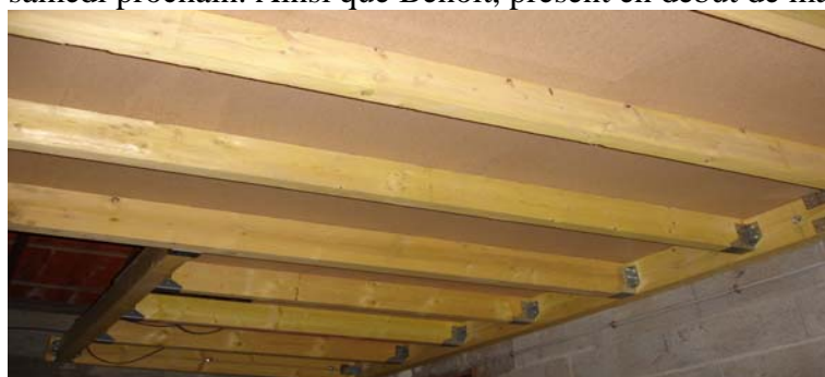
Pose du plancher...
